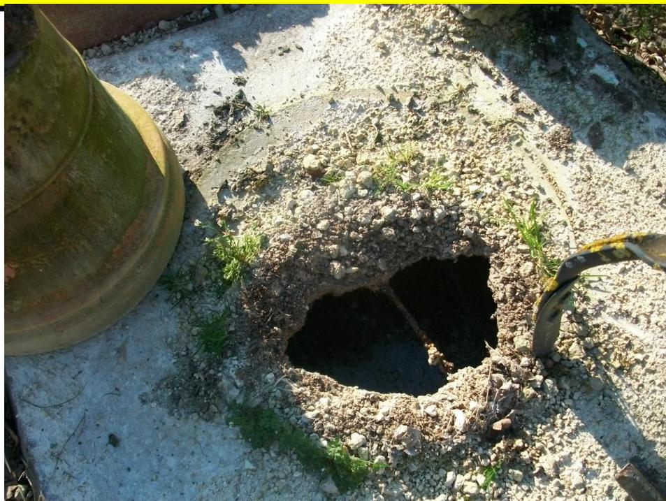
corrosion importante des fosses en béton
