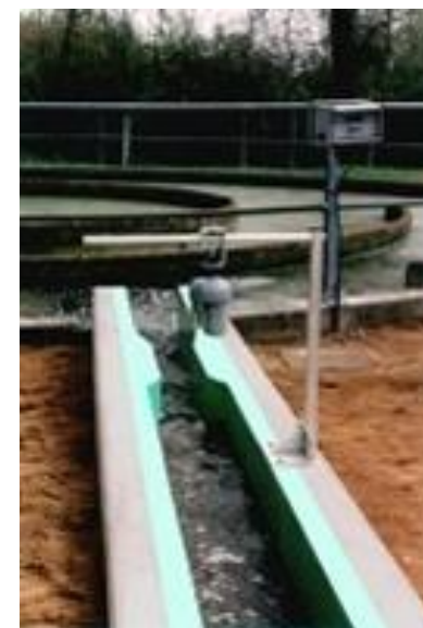
Ex de canal Venturi à l'aval d'une STEU
